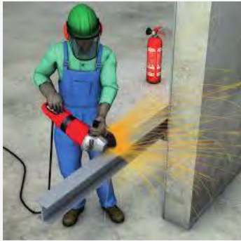
Travaux points chauds Permis feu
